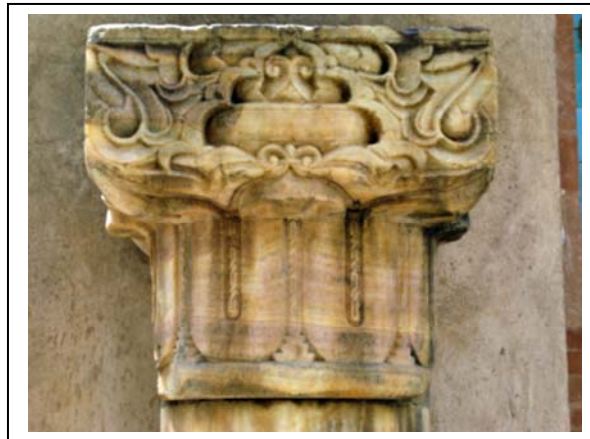
pl. III - Chapiteau type B. Extérieur de la mosquée Sidi bel Hasan, Tlemcen
