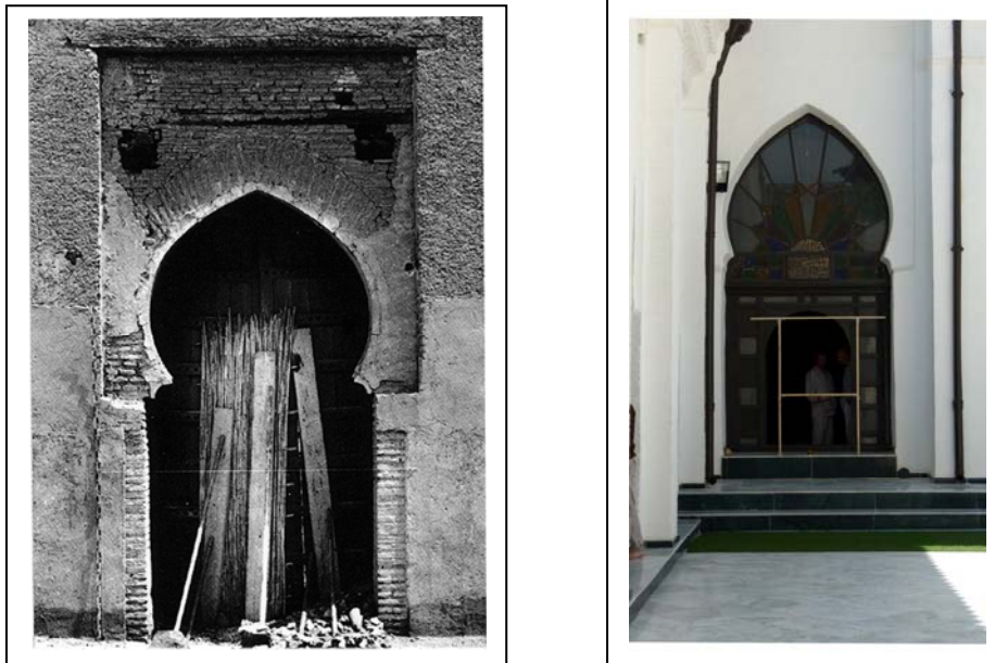
fig. 7 - Arc outrepassé brisés almohades. Tinmal (à gauche) et Tlemcen (à droite) (Michel Terrasse)
