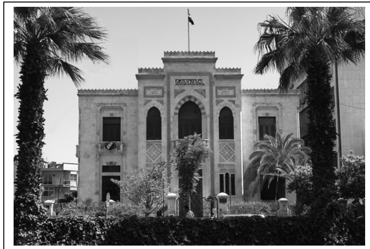
pl. VII - Service des Eaux de 'Ayn al-Fijeh, style syrien des années 1910-1950, Damas, rue al-Naṣr. Architecte Abd al-Razzāq Malas
