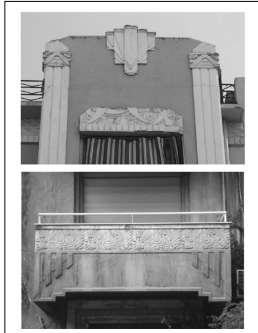
pl. IX - Deux immeubles de style Art-déco construits pendant les années 1930-1940, à Tlemcen (en haut), et à Damas (en bas).
