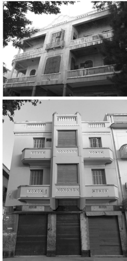
pl. X - Deux immeubles de style international construits pendant les années 1930-1940 à Damas (en haut) et à Tlemcen (en bas).
